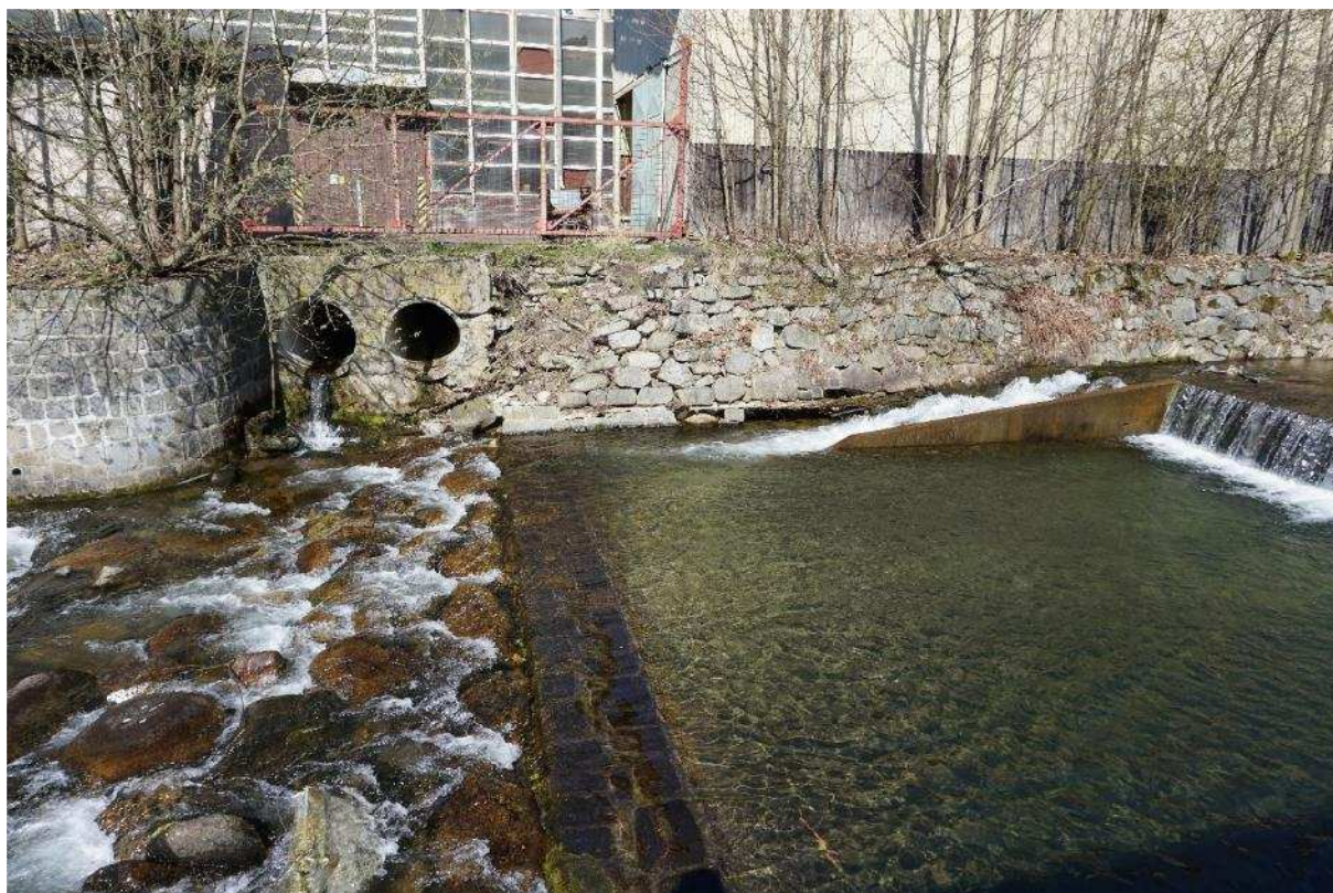
1. SO 01 - ř.km 28,880 – spádový stupeň včetně výusti 2 x DN1000
