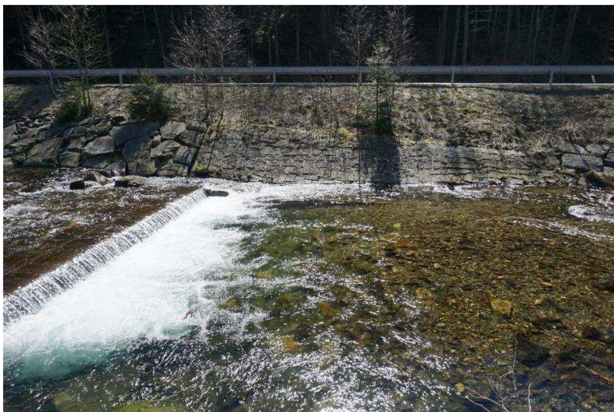
13. SO 03 – ř.km 32,310 – oprava spádového stupně
