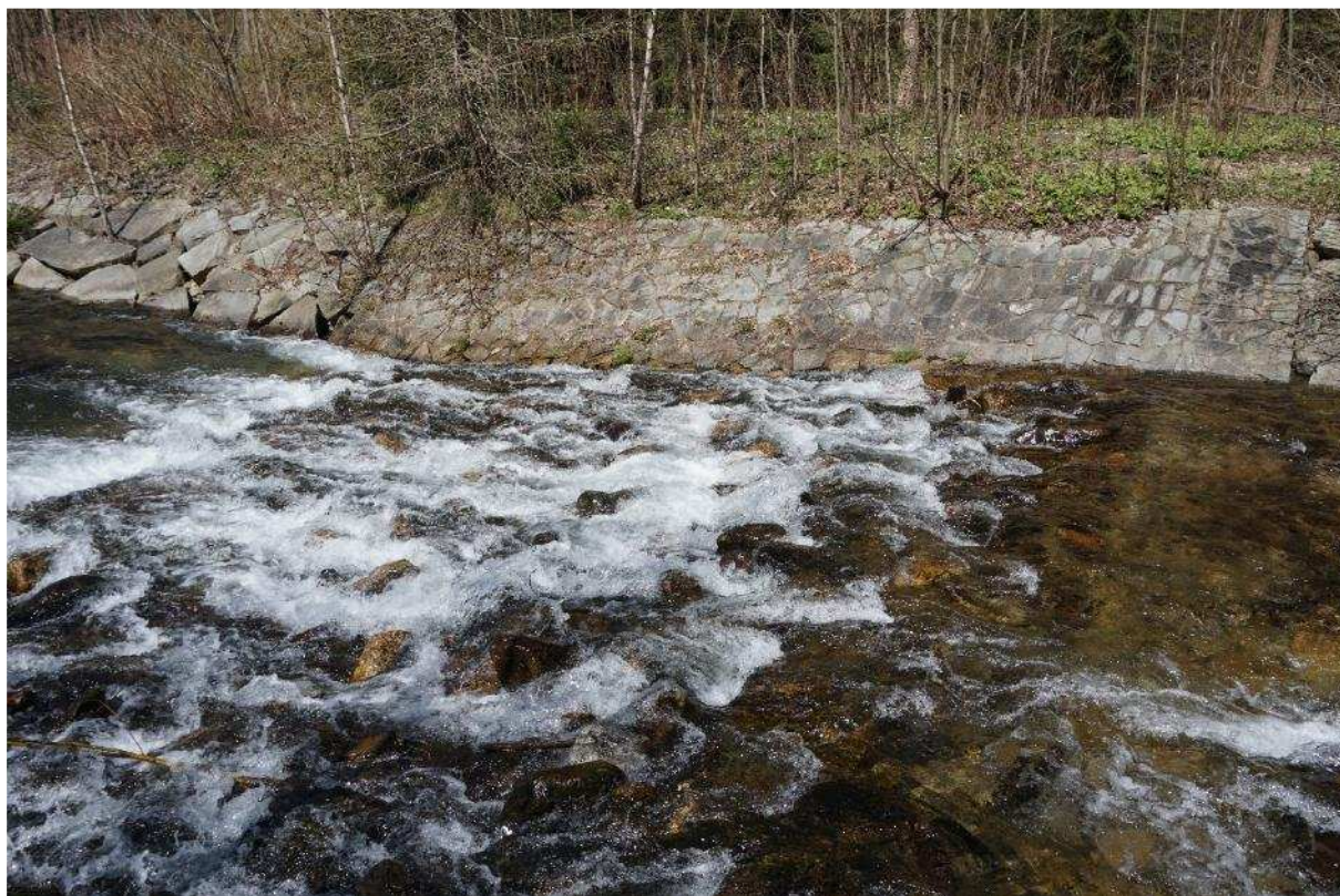
18. SO 03 – ř.km 32,610 – oprava balvanitého skluzu
