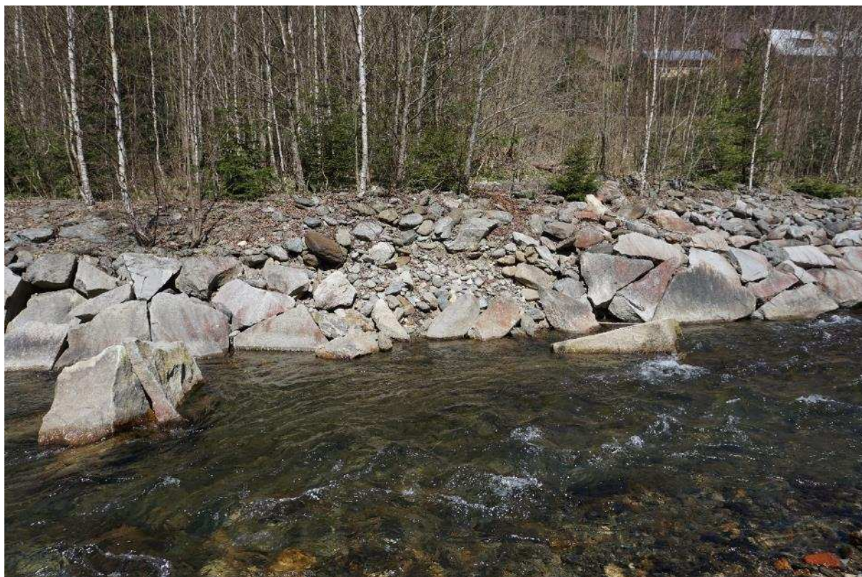
16. SO 03 – ř.km 32,465 – 32,559 – oprava opevnění na PB
